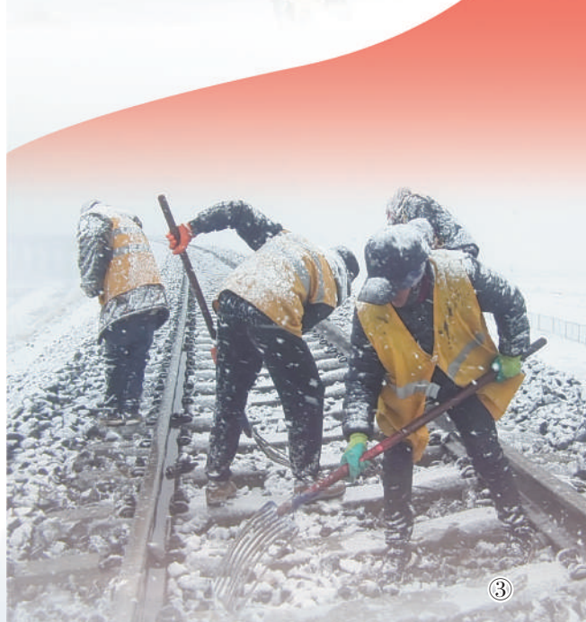
图①:青藏铁路隧道施工时经常发生塌方,建设者奋不顾身开展抢险修复工作。资料照片 图②:西宁开往拉萨的列车上,乘务人员与旅客联欢。资料照片 图③:中国铁路青藏集团公司职工冒雪对整修后的道床进行清理。马祚俊摄 图④:青藏铁路沿线风光。资料照片
